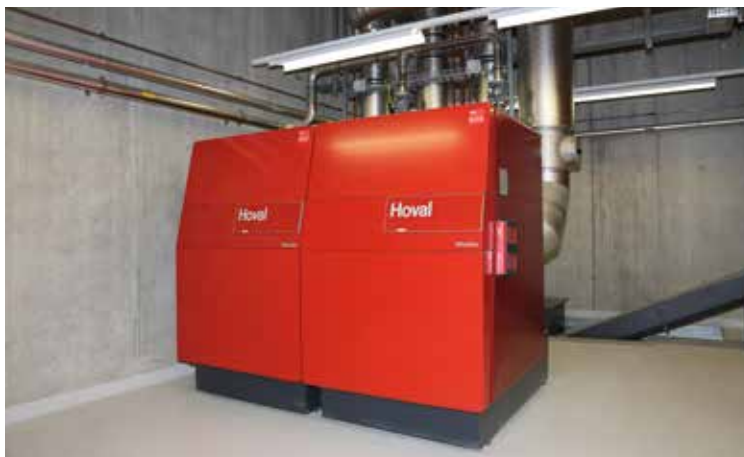
Centrale de chauffe pour réseau de chauffage à distance: 1 UltraGas double (1300D) garanti la plus grande efficacité et sécurité de fonctionnement.
