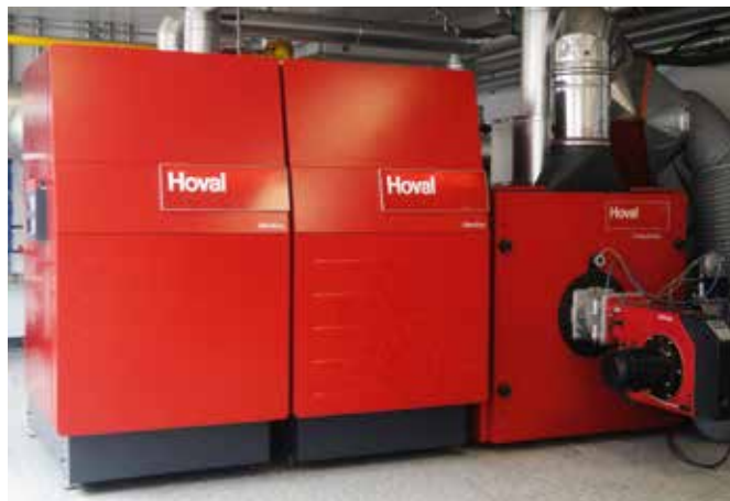
Cascade monovalente de 2 UltraGas® et d'1 CompactGas dans la centrale de chauffage.
