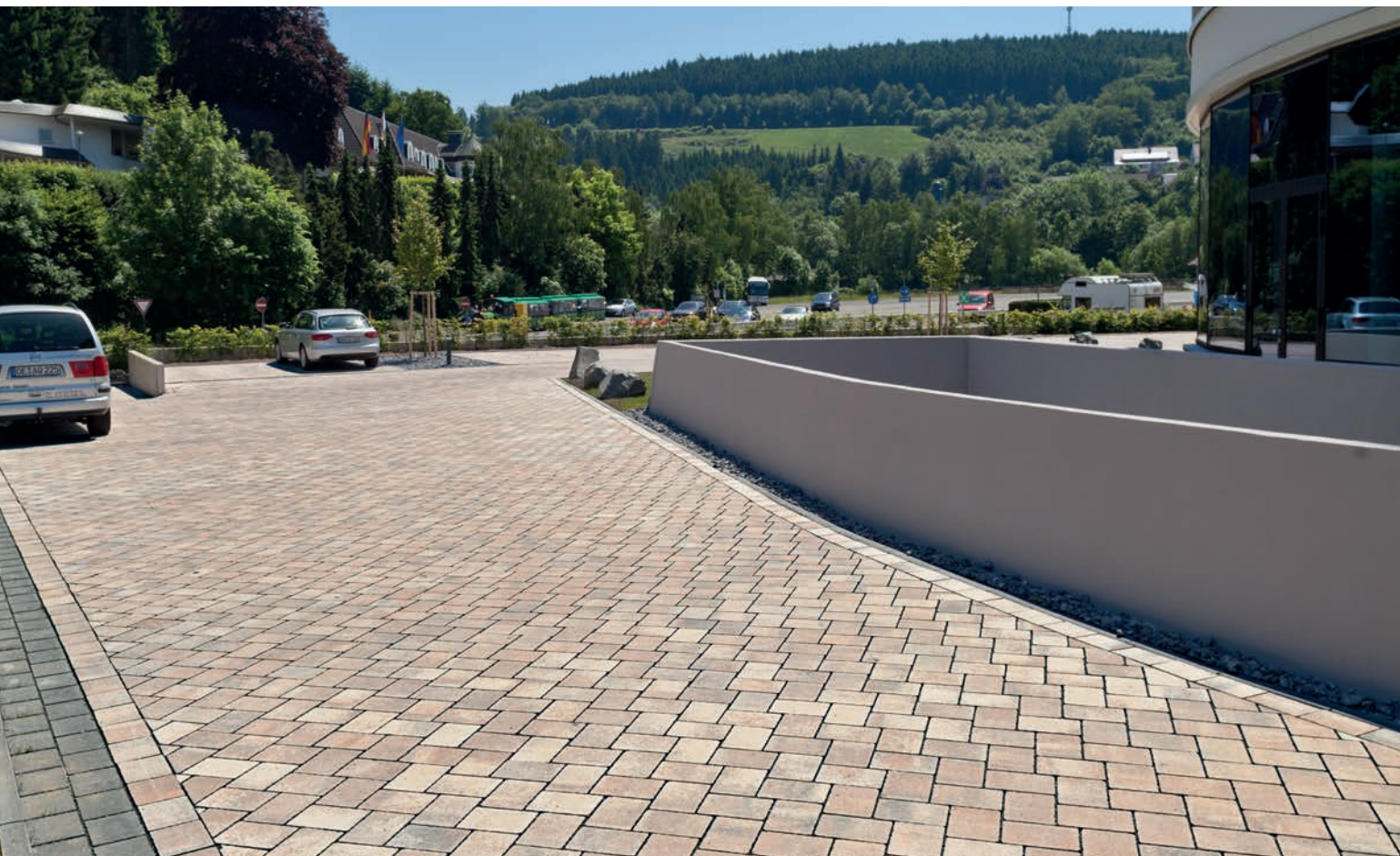
Fischgrätverband, geeignet bis Belastungsklasse Bk3,2
