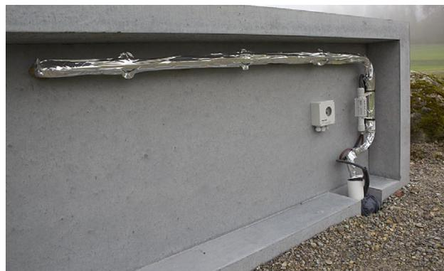
Rückwand bei der Ausführung «frostsicher», nach der Installation der Sanitärteile, vor dem Einbringen des Isolationsmaterials und der Befestigung der Rückwand. Diese Arbeiten werden vor Ort von einem zu beauftragenden Sanitärfachmann ausgeführt.
