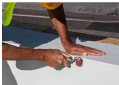
Le SikaRoof AT flexible avec les nouveaux composants du système tels que le SikaRoof AT FSA P autocollant et le SikaRoof Tape P permettent une application simple et surtout rapide, même dans la conception des détails.
