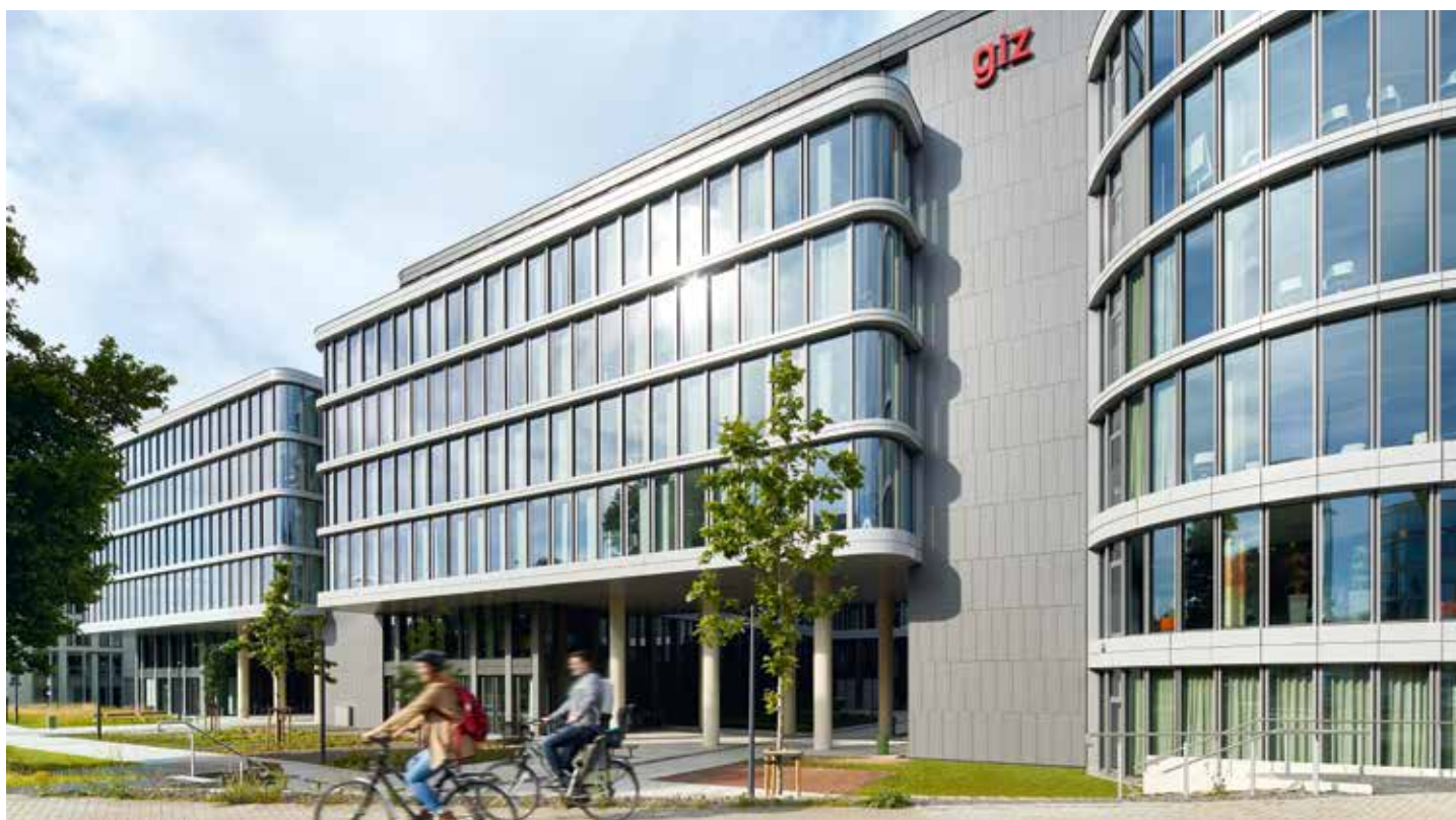
GIZ Campus, Bonn, Allemagne / Architecte : CLP GmbH, Coblenz / Année : 2019 / Photo : Jochen Stüber
