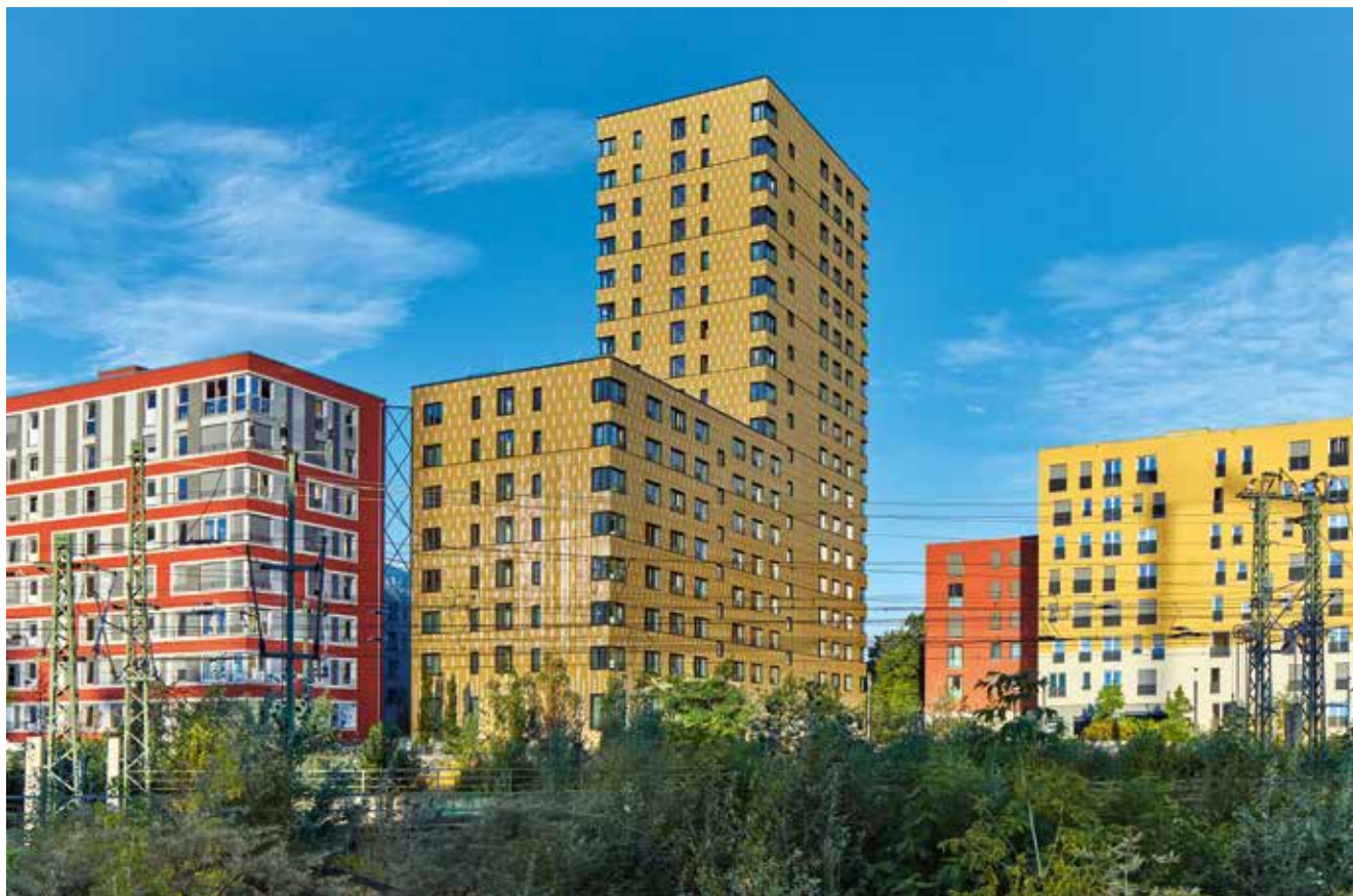
Fritz Tower, Berlin, Allemagne / Architecte : Sauerbruch Hutton, Berlin / Année : 2020 / Produits : Craft fabrication hors série spécifique au projet / Photos : Jochen Stüber
