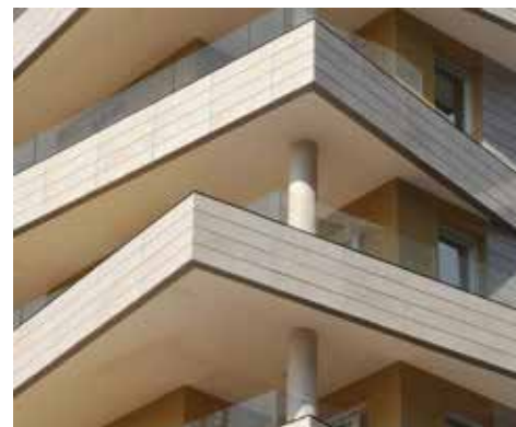
Edificio Albia, Bilbao, Espagne / Architecte : Tabuena y Salategui Arquitectos / Année : 2019 / Photo : Joaquin Prat
