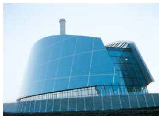
Usine combinée de chaleur et électricité, Viborg, Danemark / architecte : Arkitekterne, Peter Kjølgaard & Thomas Pedersen M.A.A., Viborg
