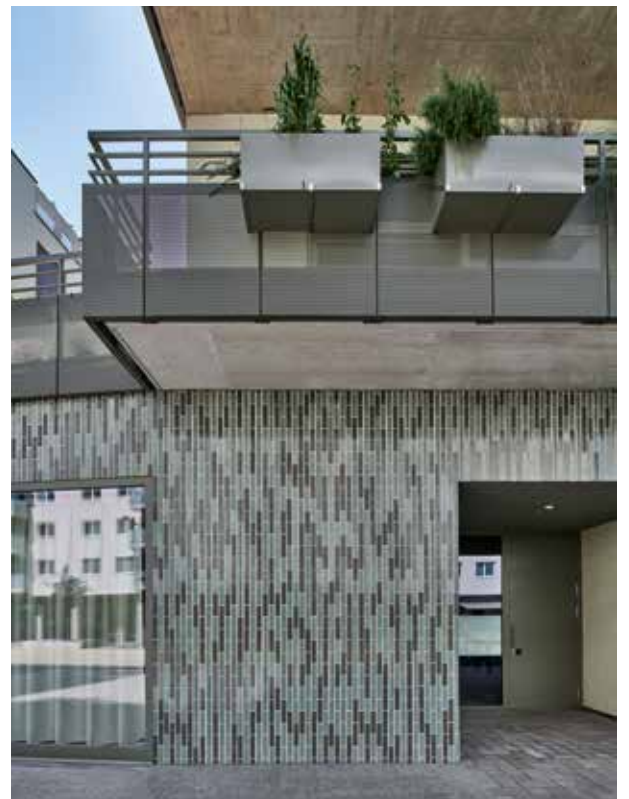
Grätzelmixer, Vienne, Autriche / Architecte : KABE Architekten ZT-GmbH, Vienne, Autriche / Année : 2019 / Produits : Craft Photos : Fotodesign Peters, Amerang
