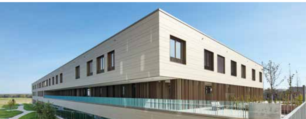
Tagesklinik (Clinique de jour) ZfP Südwürttemberg, Biberach, Allemagne Architecte : Die Ulmer Architekten BDA / Année : 2020 / Photo : Conné Van D'Grachten
