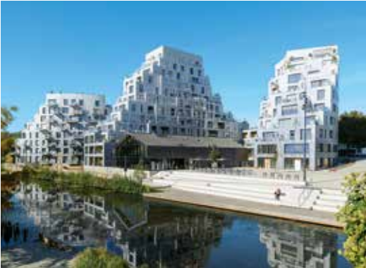
Îlot de l'Octroi, Rennes, France architecte : MVRDV, Rotterdam, Pays-Bas
