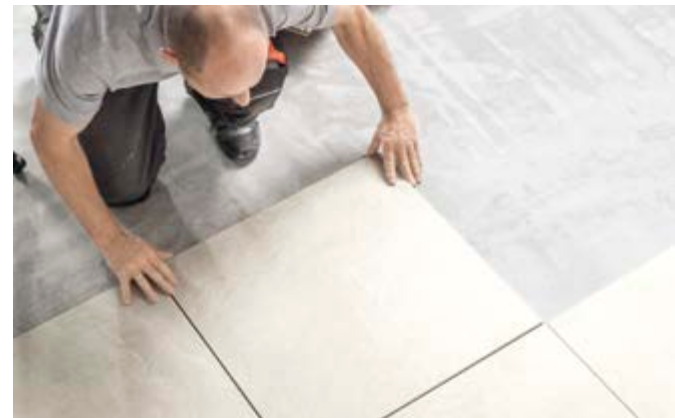
3 Fugenraster festlegen und Korkkanten press aneinander legen.
