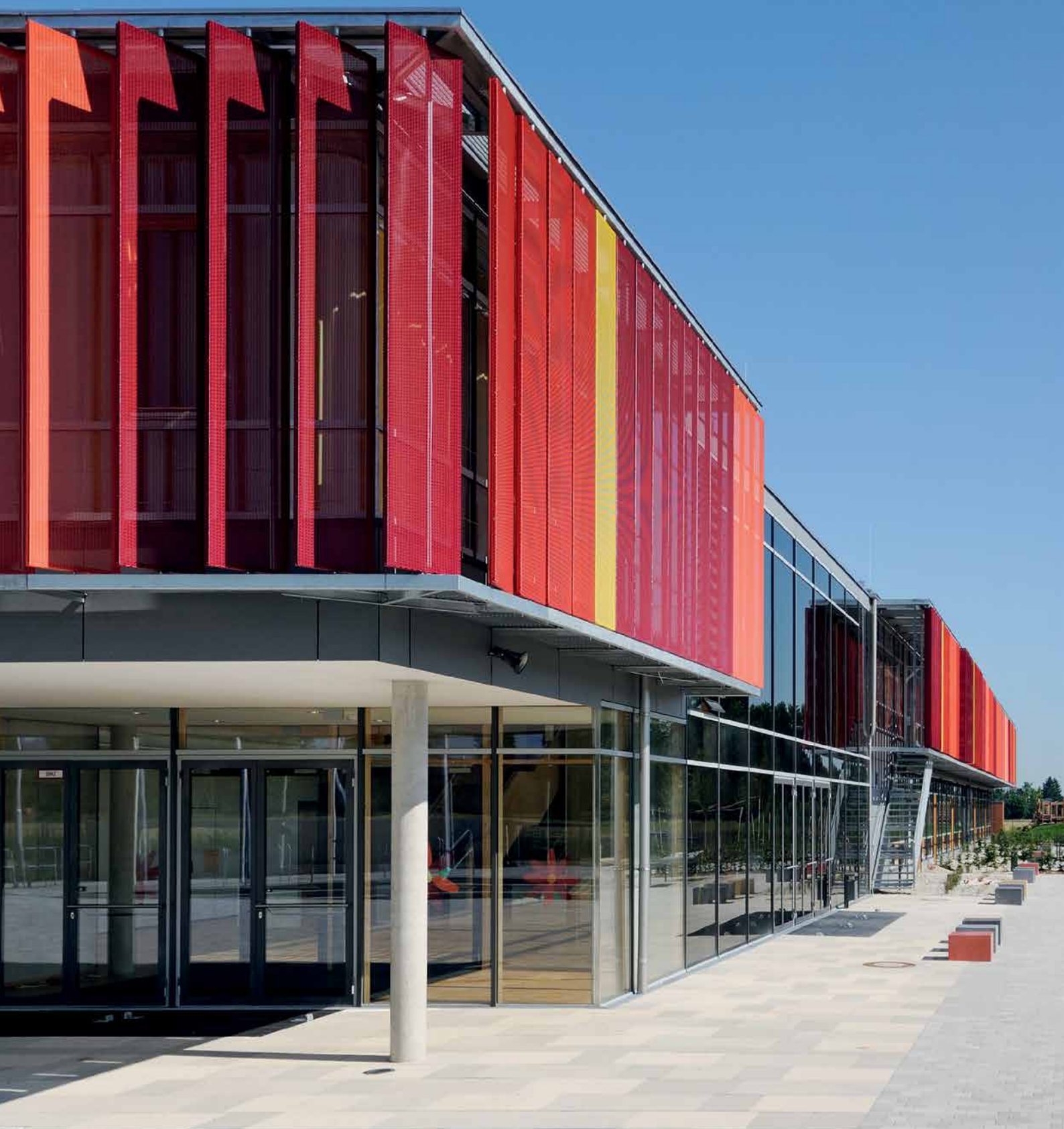
Grundschule – Neubiberg, DE
