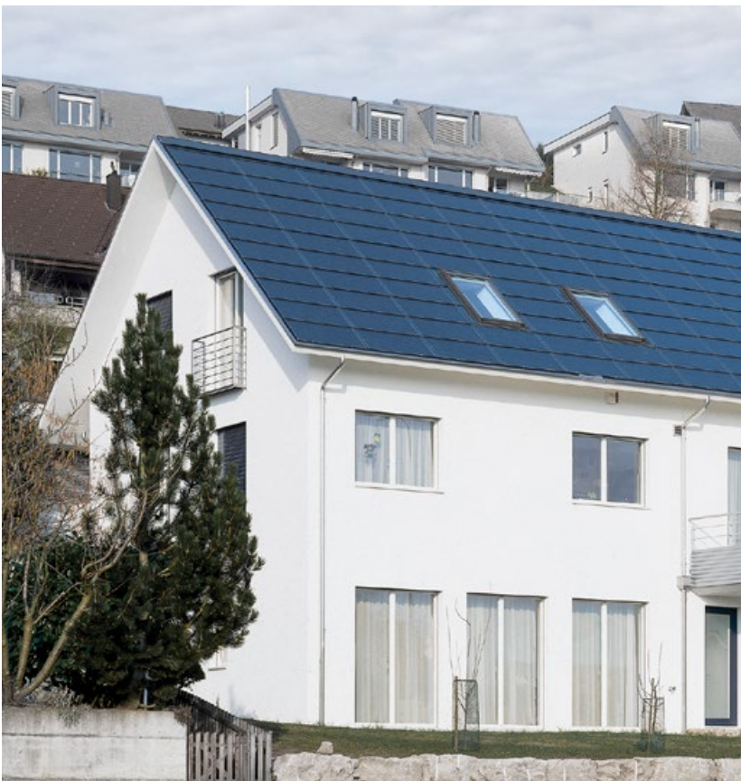
Einfamilienhaus Obersiggenthal (Schweiz)
