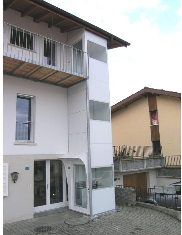
Liftschacht unter Dachschräge eingepasst, nachträglicher Einbau
