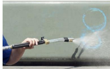
**PSS 20® Polysaccharid-Technologie:** Gerade an historischen Fassaden zeichnet sich das Opferschichtsystem durch seine rückstandslose Graffiti-entfernung aus. Eine weitere Anwendung: Bauphasenschutz.
