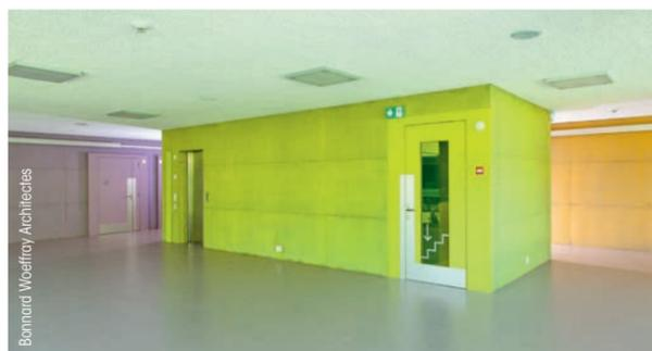
Mit der PSS faceal Colour® Technologie werden Sichtbeton-Oberflächen in deren typischen Optik und charakteristischen Haptik gestaltet und veredelt – ausgewählt aus über 100 Standard- und dem ganzen Spektrum an NCS- und RAL-Farbtönen:
