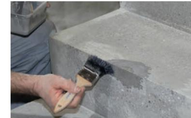
**PSS Reprofilierung:** Ausbrüche, Lunker, Nester, usw. werden substanziiell aufgearbeitet. Die ausgebesserten Stellen werden retuschiert und optisch angepasst.
