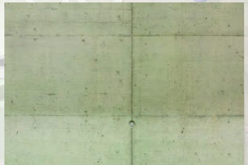
Farbiger Beton mit typisch lebhafter Betonoptik – dank perfekt eingestelltem Deckungsgrad | ewz Zürich
