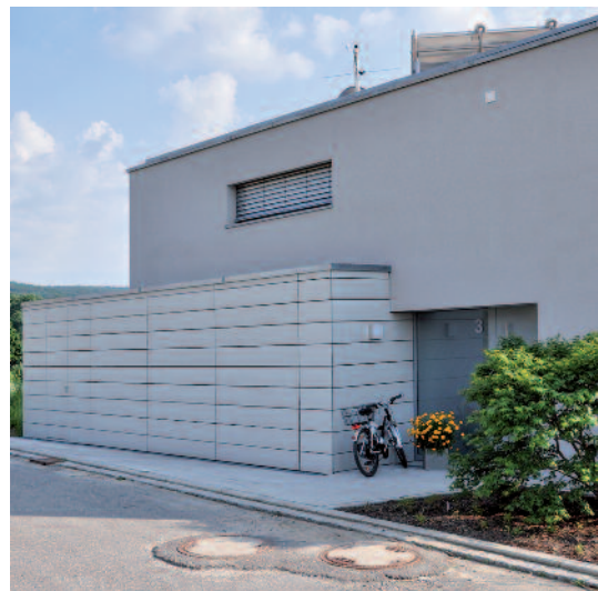
Flächenbündige Toranlage mit Fassadenplatten
