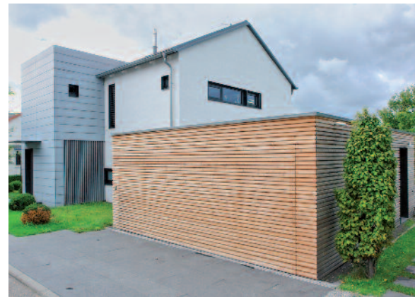
Flächenbündiges Kipptor mit Profil-Schalung aus Lärchenholz
