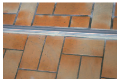
Damit nichts rostet – Schwellenschiene aus V2A
