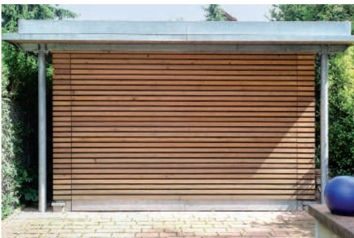
Flächenbündige Tore aus Okoume Bootsbauplatte
