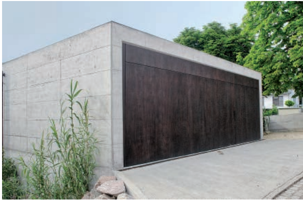
Flächenbündige Tore aus Okoume Bootsbauplatte
