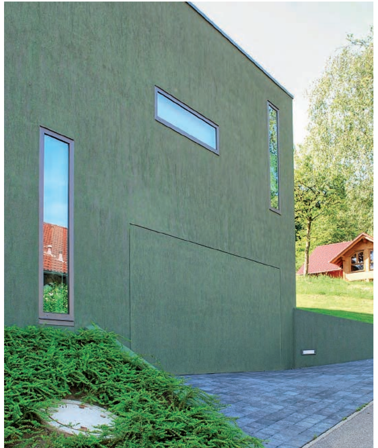
Das Tor wurde in den Vollwärmeschutz integriert und bauseitig mit Edelputz überzogen.
