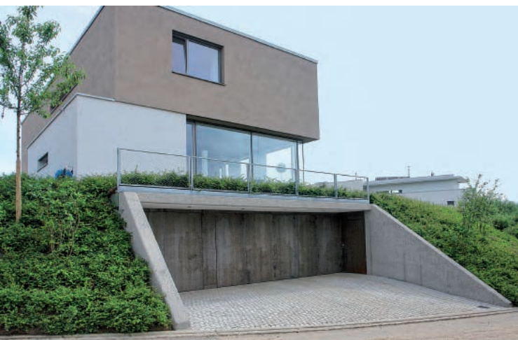
Kipptor bauseitig mit Cortenstahl verkleidet
