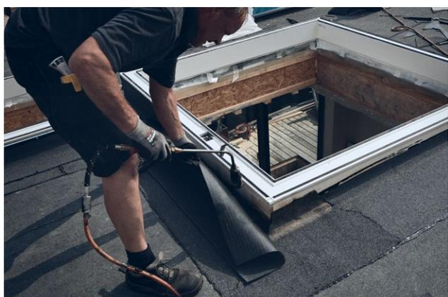
Mise en sécurité de la trémie et mise en place de l'étanchéité sur la costière, sans exposer le produit à la flamme.
