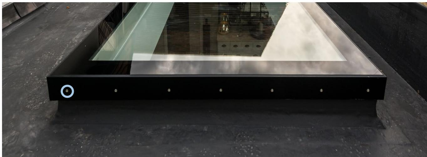
Fixation renforcée de l'unité supérieure sur la costière et au toit.
