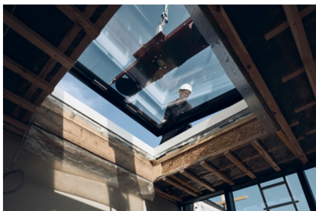
Der Glasaufsatz wird montiert
