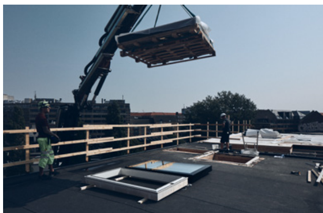
Die Module werden auf das Dach befördert
