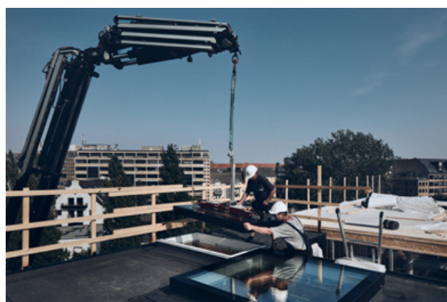
Der Glasaufsatz wird montiert
