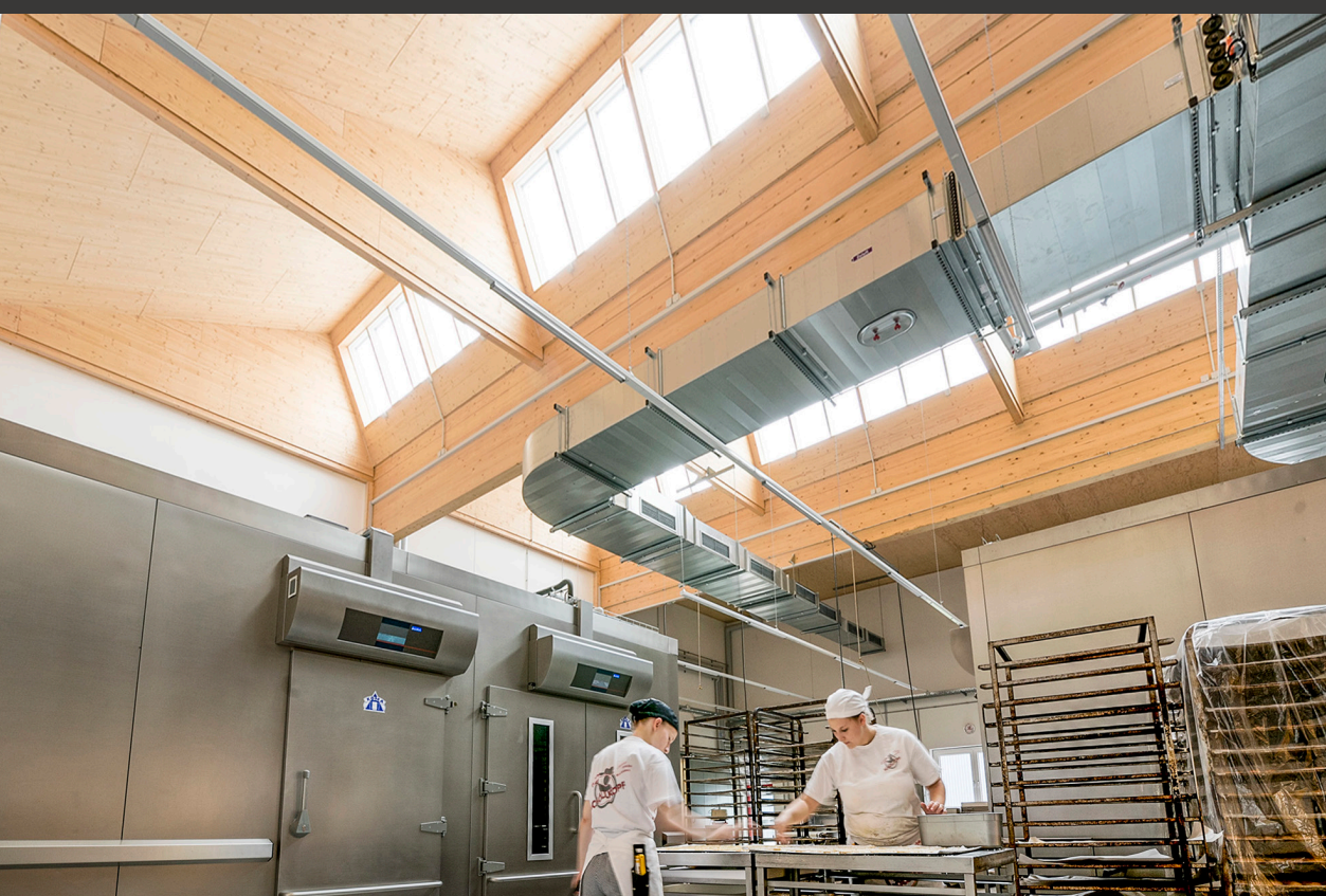
Schöllkopf Backwaren, Waiblingen, Allemagne. Trois Sheds, 54 modules.
