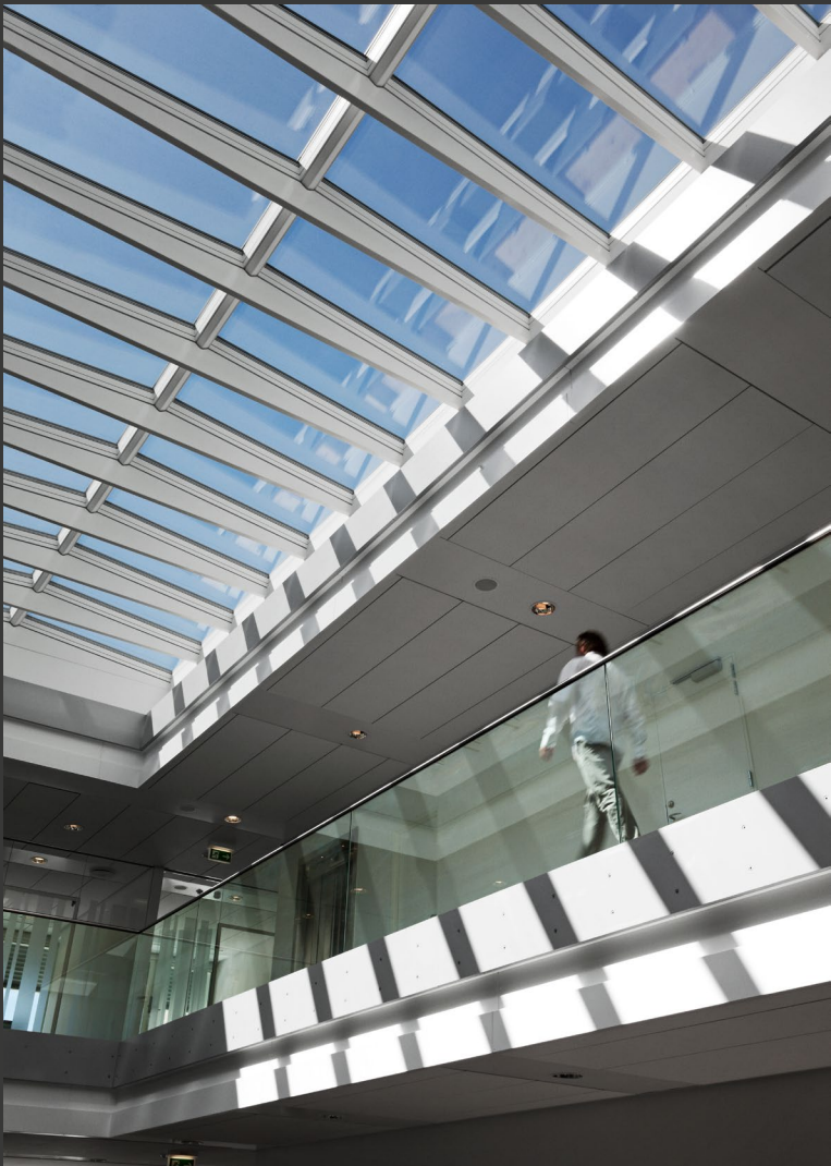
ATP, Vordingborg, Dänemark. Sattel-Lichtband 5° mit Träger, 26 Module.
