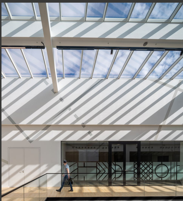
Siège Social Actis Isolation, Limoux, Frankreich. Ein Stufen-Lichtband, 54 Module inklusive elektrochromer Verglasung.
