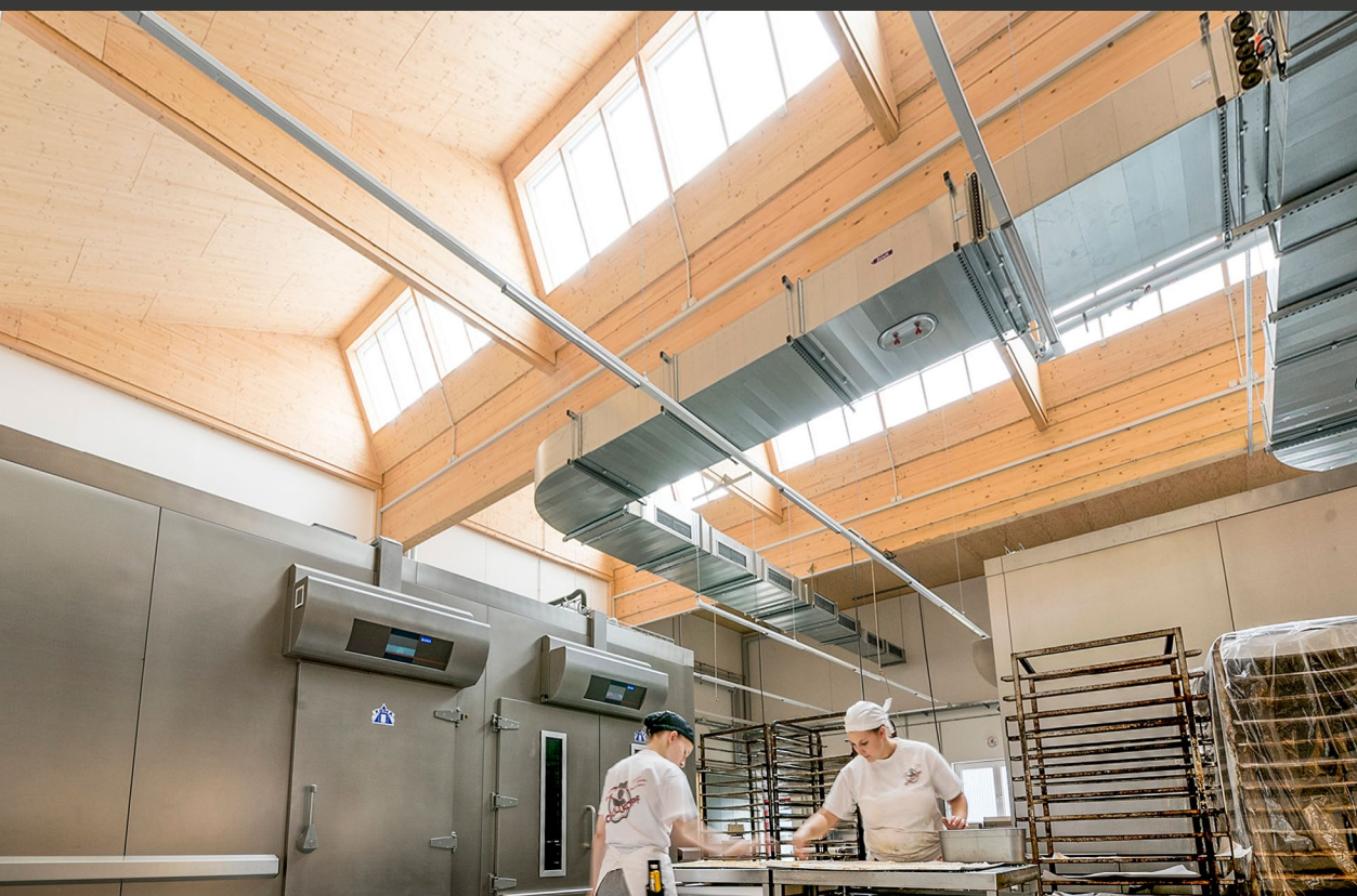
Schöllkopf Backwaren, Waiblingen, Deutschland. 3 Sheddach-Lichtbänder, 54 Module.
