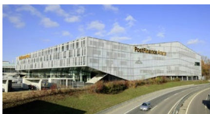
Postfinance Arena, Bern – Garderoben – Garderobenschränke
