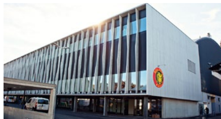
Ilfishalle, Langnau – Garderoben – Garderobenschränke
