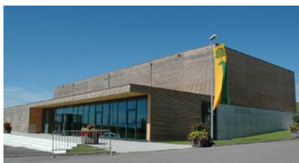
Mehrzweckhalle, Neuheim – Garderoben
