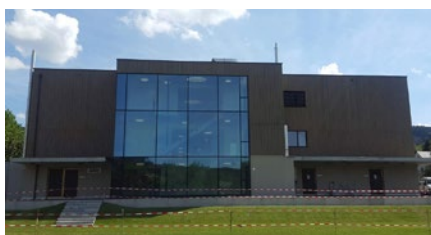
Erweiterung Schulanlage, Arisdorf – Garderoben
