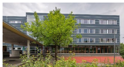
Primarschulhaus Telli, Aarau – Garderoben
