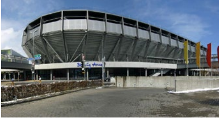
AFG Arena, St. Gallen – Garderoben – Garderobenschränke
