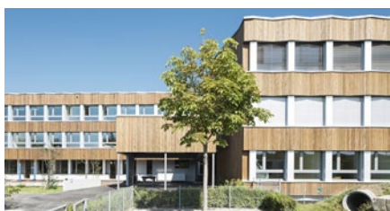
Schulhaus Säget, Jegenstorf – Garderoben
