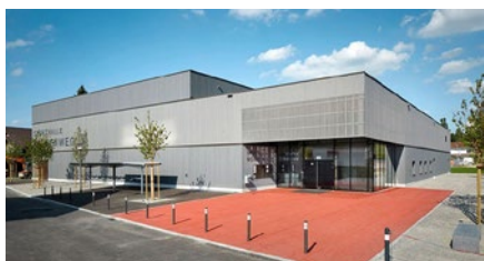
Neubau 3-fach Turnhalle, Schötz – Garderoben – Anschlagkasten
