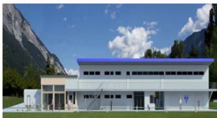
Garderobengebäude, Domat/Ems – Garderoben – Wertsachentresore
