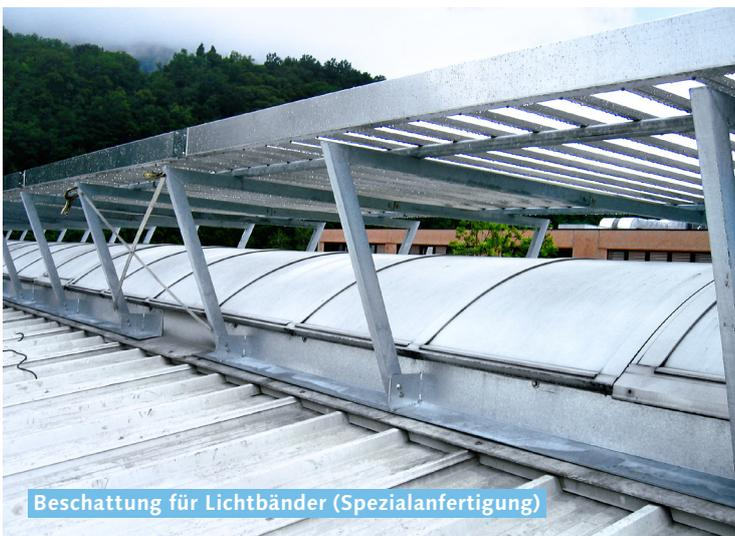
Es sind auch Spezialanfertigungen möglich wie bei diesem Lichtband welches sich auf dem First eines leicht geneigten Satteldaches einer Industriehalle befindet.
