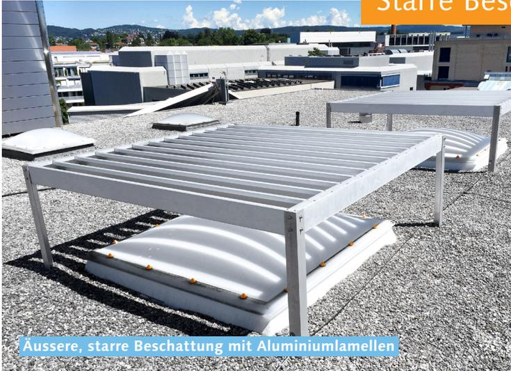
Eine sehr effiziente und unterhaltsarme Beschattung sind starre Aluminiumlamellen. Sie werden mit einer Unterkonstruktion über die Oberlichter gestellt und auf Gehwegplatten befestigt, welche lose auf die Nutz- und Schutzbeschichtung des Flachdachs verlegt werden. Die Gehwegplatten werden so dimensioniert, dass sie die Konstruktion auch beim stürmischen Winden an Ort und Stelle halten. Es ist daher nicht nötig die Dachabdichtung mit Befestigungsschrauben zu perforieren.
