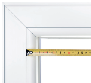
Empfohlener Messpunkt: Glasleistenfuge ggf. auf Beschläge achten
