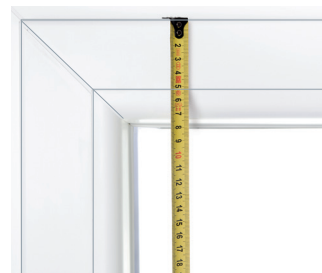
Fertige Höhe: Empfohlener Messpunkt: Ende Fensterflügel
