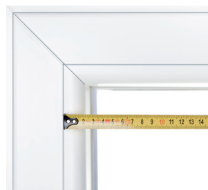
Empfohlener Messpunkt: Glasleistenfuge ggf. auf Beschläge achten
