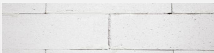
Maçonnerie simple, béton cellulaire 24 cm avec crépi intérieur et extérieur
