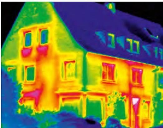
Wärmebrücken gelten als einer der grössten Schwachpunkte bei der Innenwärmedämmung. Durch einen erhöhten Wärmestrom und dadurch bedingte, niedrige innenseitige Oberflächentemperaturen kann es an diesen kritischen Stellen zu Tauwasser- und Schimmelbildung kommen. Im Bereich der Innenwärmedämmung sind die hauptsächlichen Schwachstellen:
