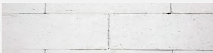
Einsteinmauerwerk Porenbeton 24 cm
