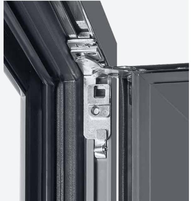
Points de rotation supérieur et inférieur avec réglage 3D aisément accessible.
