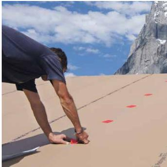
Anbringen der Schraubendichtungen direkt auf der Unterdachbahn.
