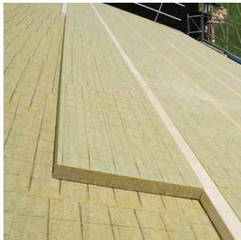
Zweischichtiger Dachaufbau bis 300 mm Dämmdicke.
