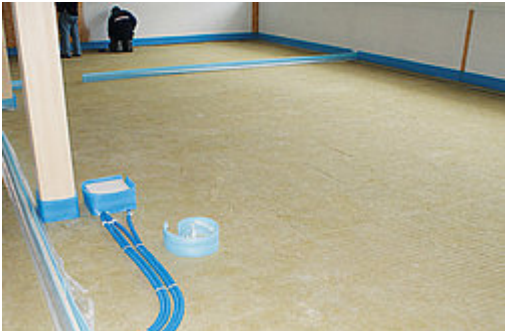
Homogene, widerstandsfähige Dämmplatte für erhöhte mechanische Belastungen unter schwimmenden Unterlagsböden. Als Kerndämmung bei zweischaligen Betonwänden.
