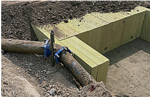
Elemente aus Steinwolle für ein kurz- oder längerfristiges Zurückhalten von Regenwasser.
