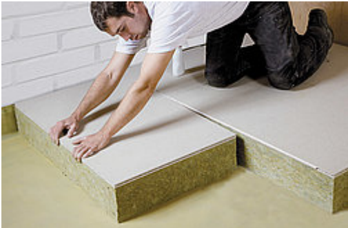
Homogene Dämmplatte im Verbund mit einer genuteten 16 mm Holzspanplatte als begehbare Dämmelement für den Dachboden-Estrich. Hartholzfedern für die Montage werden mitgeliefert.
