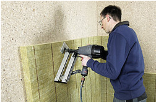
Zweischichtige Dämmplatte mit spezieller Oberfläche. Beste Putzhaftung für verputzte Aussenwärmedämmsysteme im Holzbau. Geklammert auf Untergründe aus Plattenwerkstoffen.
