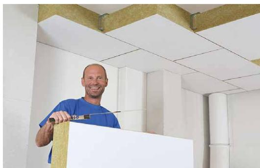
Panneau isolant homogène avec surface apparente en voile de verre blanc. Bords intégralement chanfreinés, sans revêtement. Pour les plafonds de caves, de halles et de garages souterrains avec de très bonnes propriétés d'absorption phonique.
