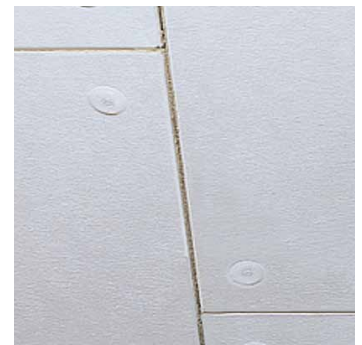
Montage mit Spezialdübel.
