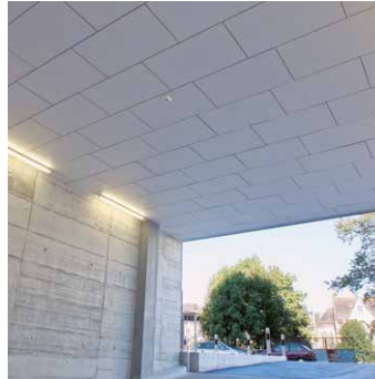
Beispiel einer Tiefgarageneinfahrt.
