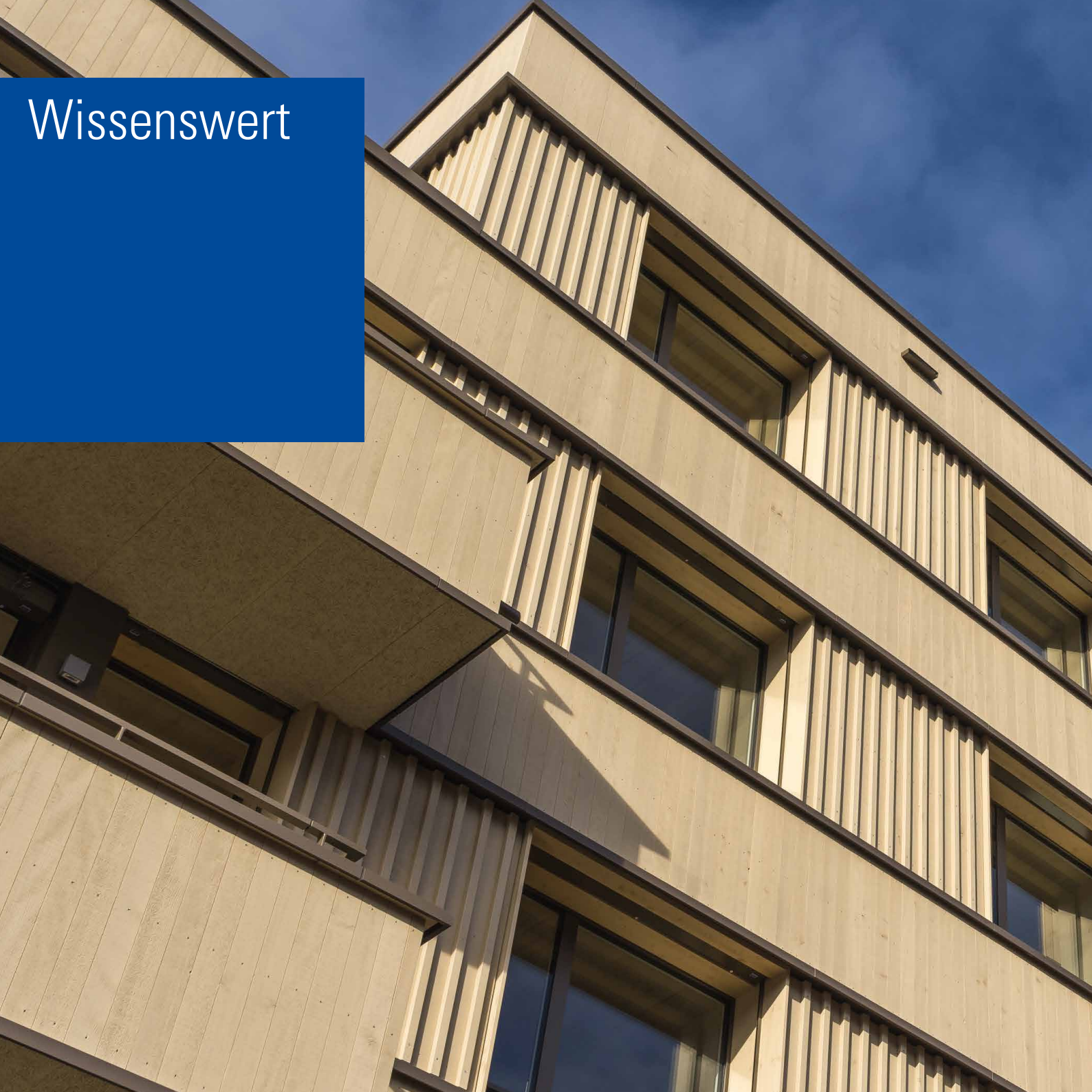
Projekt: Überbauung Schönenbrunnen, 3123 Belp, BE
