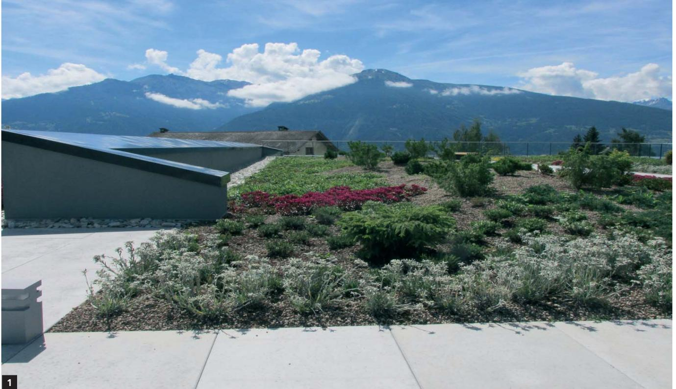
1 Toiture compacte FOAMGLAS® végétalisée, avec gravier et dallage
