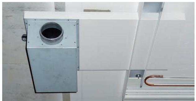
Luftanschlusskasten mit integriertem Telefonieschalldämpfer
