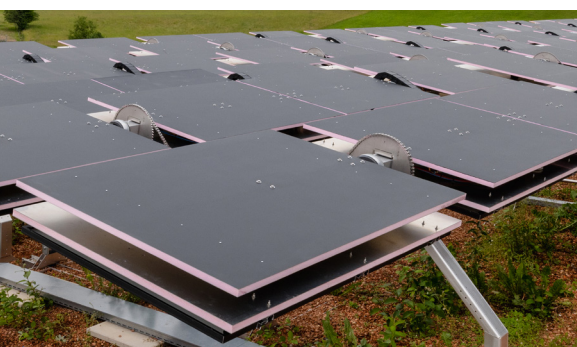
Emitter-Modul für die Wärmeüberschussabgabe.
