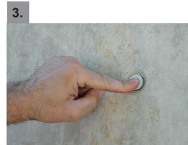
3. Distanzrohre beidseitig mit Verschlusszapfen verschliessen. Bei wasserdichten Bindestellen zusätzlich Fluppzapfen verwenden.
