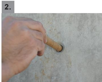
2. Den nassen BSS Akustik-Schallschutzstopfen in die Bindestelle stecken.
