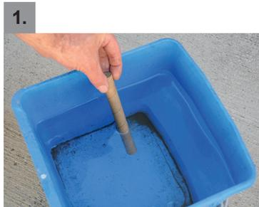
1. BSS Akustik-Schallschutzstopfen ins Wasser eintauchen. (Bei Brandschutzanwendung hier ANTIFLAME 2050 W verwenden!)
