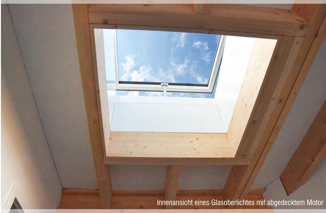
Innenansicht eines Glasoberlichtes mit abgedecktem Motor
