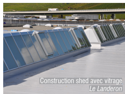
Forme classique d'un toit shed
