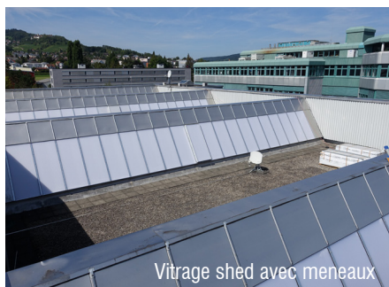
Vitrage shed avec meneaux
