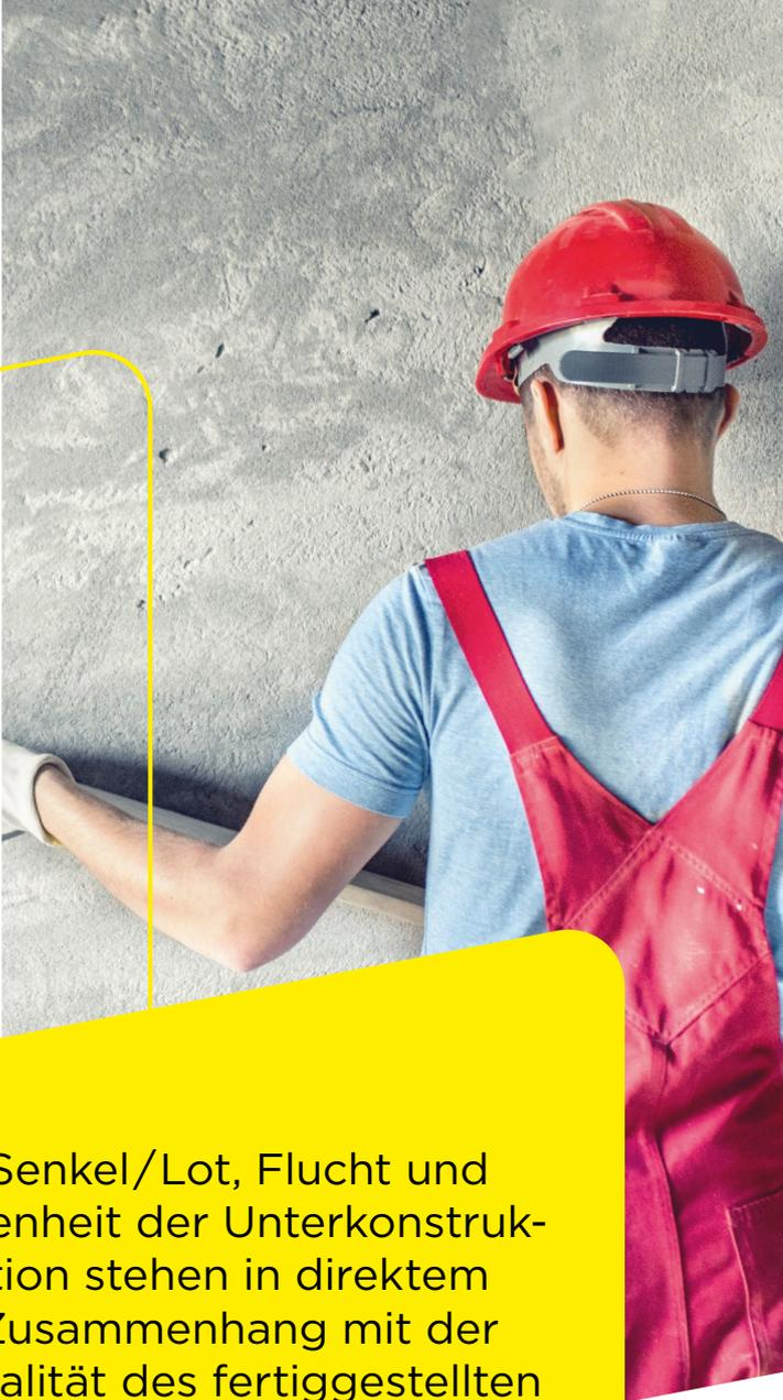
Senkel/Lot, Flucht und Ebenheit der Unterkonstruktion stehen in direktem Zusammenhang mit der Qualität des fertiggestellten Werkes.
