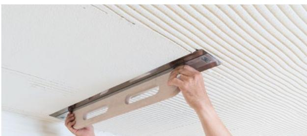
Étaler MARMORAN Acoustic Basecoat avec la spatule de lissage MINI, respectivement avec la spatule de lissage BIG.
