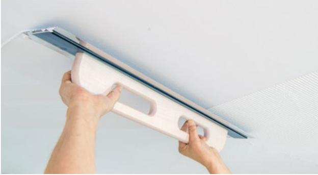
Appliquer et lisser MARMORAN Acoustic Topcoat avec la spatule de lissage.
