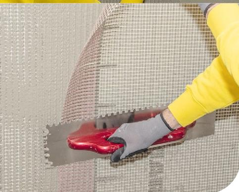
Il faut respecter un recouvrement minimal des lés de treillis d'au moins 10 cm pour tous les travaux avec des treillis d'armature.
