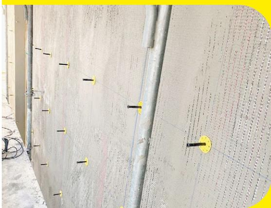
Les trames indiquées pour les chevilles s'appliquent à des bâtiments jusqu'à 11 m. Pour les projets impliquant des bâtiments plus hauts que 11 m, et en particulier s'ils font plus de 30 m de haut, ce sont les recommandations du recueil ITEC qui s'appliquent. Selon le revêtement, l'épaisseur et le type de matériau isolant, il faudra renforcer les zones des bords et du toit avec des chevilles.
