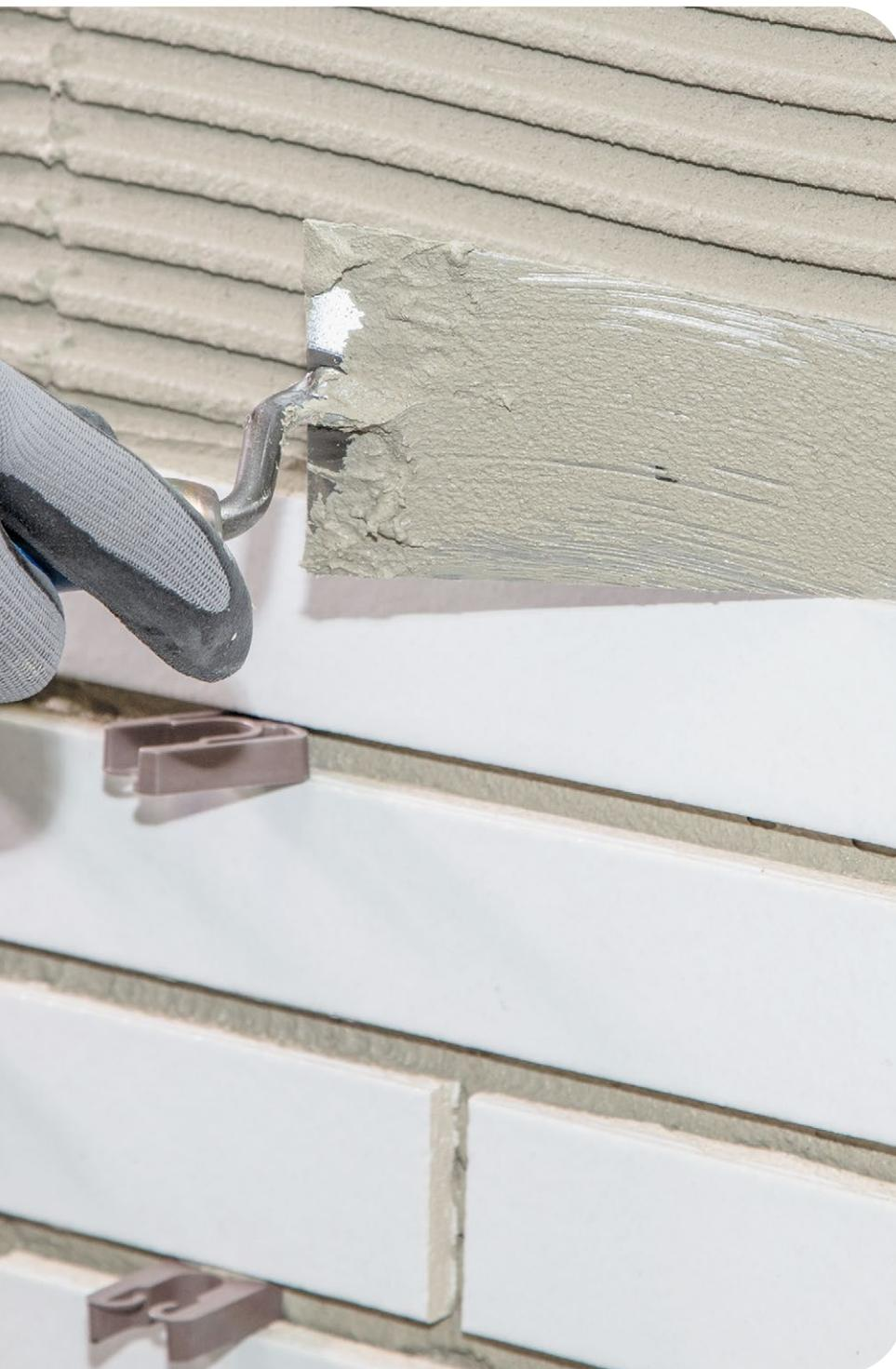
Der Ausführung des Endbelages ist besondere Beachtung zu schenken. Konstante klimatische Bedingungen sind für ein korrektes Abbinden und die Farbeinheitlichkeit von mineralischer Klebe- und Fugenmörtel eminent wichtig. Durch Witterungsschutzmassnahmen muss verhindert werden, dass die Oberfläche des frisch verlegten/verfugten Belages durch Regen oder Kondenswasser beansprucht und damit der Aushärteprozess behindert wird.
