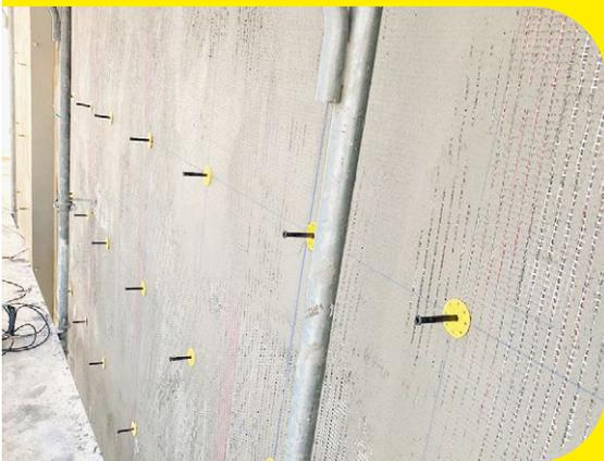
Die angezeigten Dübelraster beziehen sich auf Bauten bis 11 m. Für Projekte mit Gebäuden, die höher als 11 m und im Besonderen über 30 m sind, gelten die Empfehlungen aus dem VAWD-Kompendium. Je nach Belag, Dicke und Art des Dämmstoffes müssen die Rand- und Dachzonen verstärkt gedübelt werden.
