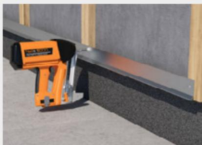
Befestigung des Sockel-Lüftungsprofil.
