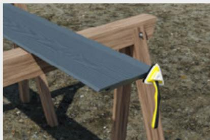
Auftragen der Hardie™ Seal Kantenversiegelung vor der Montage.
