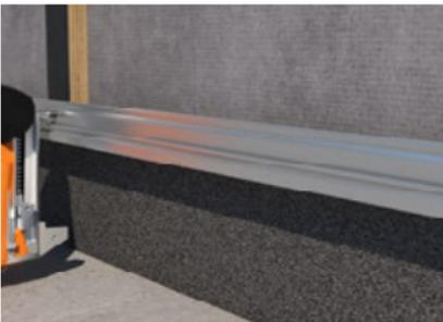
Befestigung des Starterprofils.
