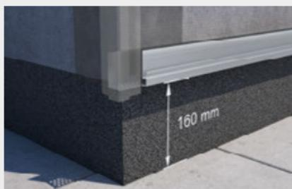
Befestigung des Starterprofils
