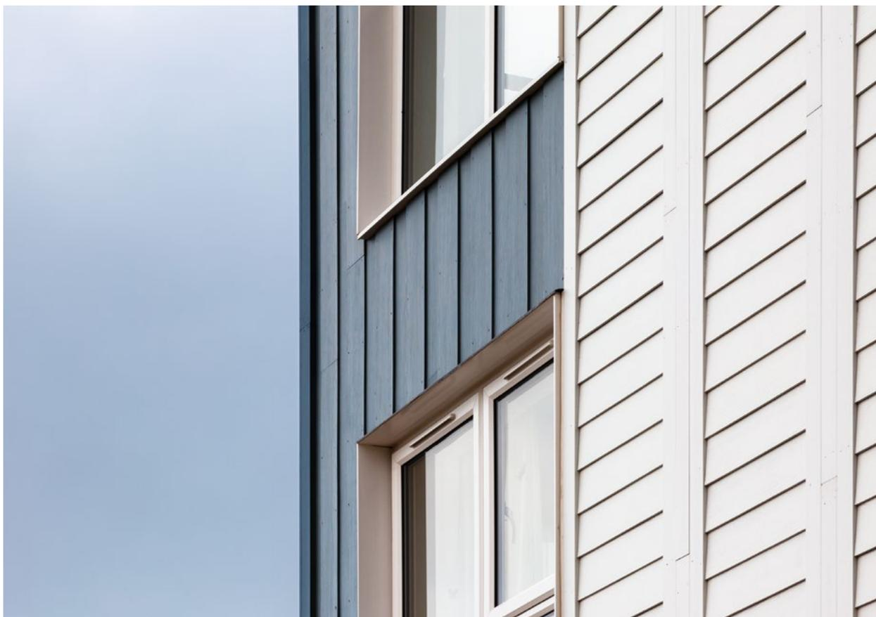
**Hardie® Plank** Fassadenpaneele als Kombination von Boden-Deckel-Schalung und Stülpchalung
