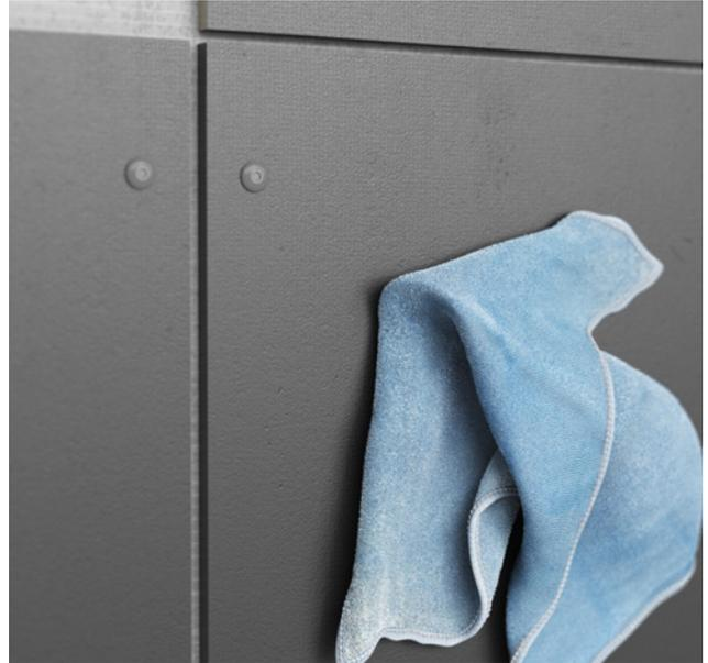
Bohr-, Schneid- und Schleifstaub sind bei der Verarbeitung der Hardie Faserzementprodukten von der Oberfläche umgehend zu entfernen. Zur Entfernung von trockenem Staub kann ein sauberes Microfasertuch, eine sehr weiche Bürste oder eine Druckluftpistole verwendet werden. Nasser Staub kann zu Flecken und weissen Schleier auf der Oberfläche führen. Nasser Staub ist umgehend mit viel Wasser und einem sauberen weichem Schwamm zu reinigen.
