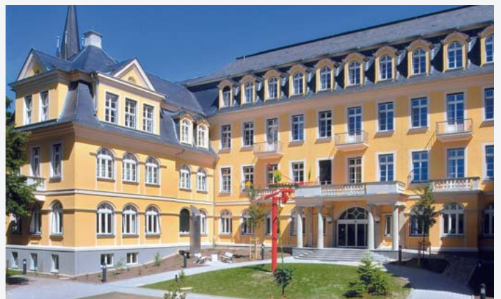
St.-Elisabeth-Krankenhaus, Halle, renoviert mit Histolith Außenquarz
