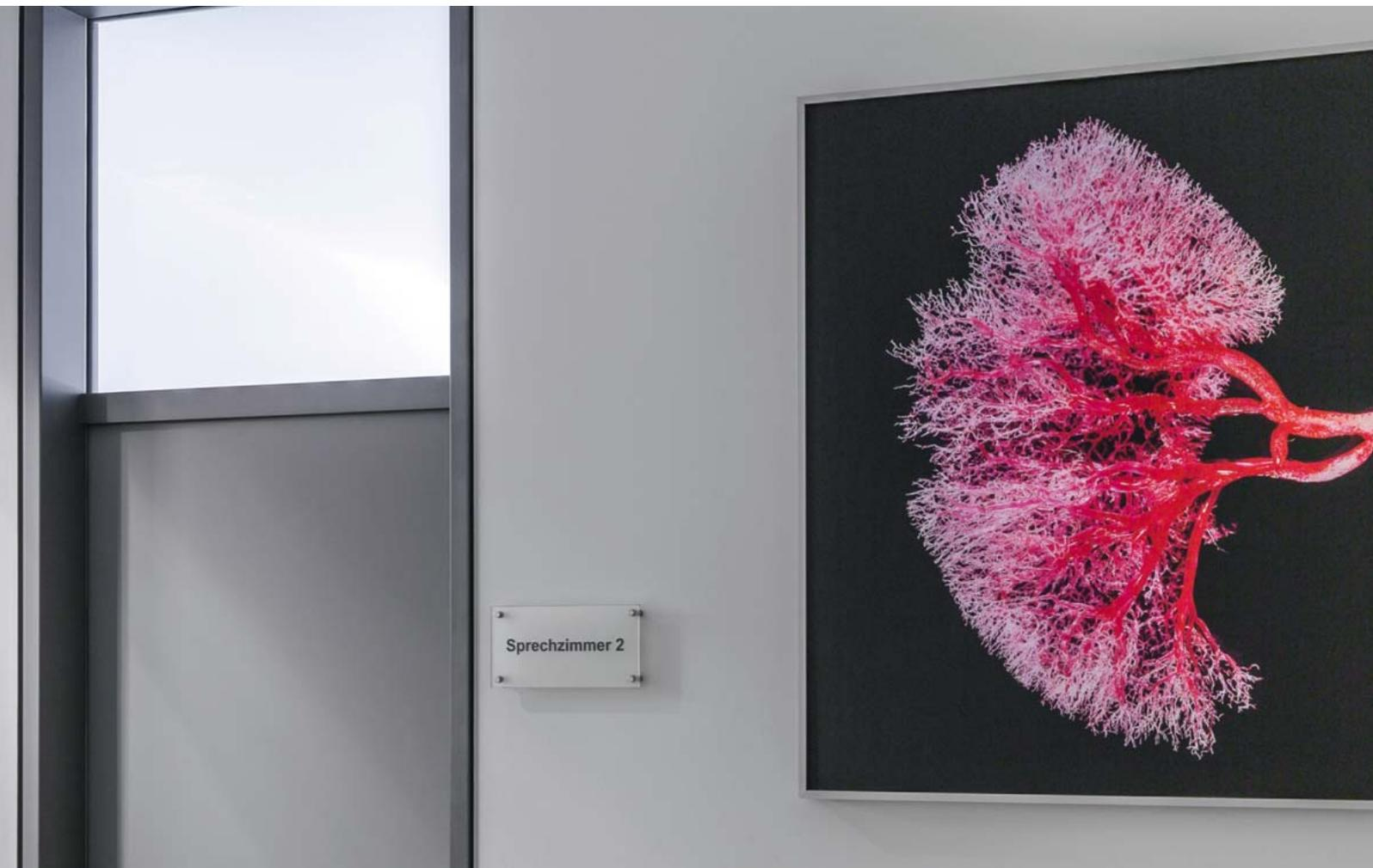
**CapaCoustic Melapor Picture:** Individuell bedruckte Schallabsorber sorgen für gute Akustik im richtigen Rahmen.
