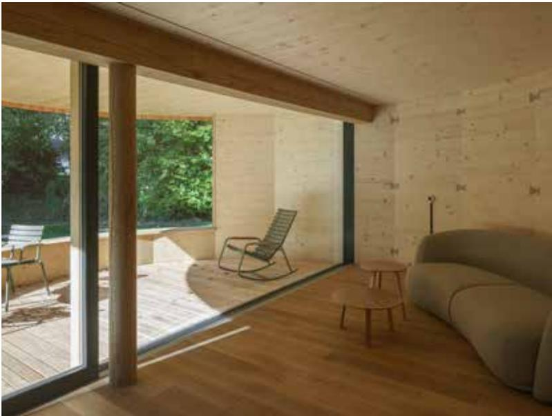
*24x30 cm misst der Eichenbalken beim Terrassenfenster. Er ermöglicht die Verbindung von Innen- und Aussenraum. Die Brettstapeldecke darüber ist nicht thermisch getrennt.*
