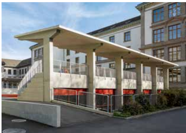
Oben: der Bestand vor der Aufstockung. Die Stützen an der Aussenseite der Fassade sind Blendstützen ohne statische Funktion.
