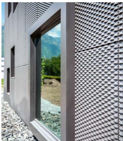
Diverse Fensterausführungen als architektonische Variable – wie hier eine von aussen vorgehängte Festverglasung.
