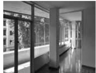
Die Stützen stehen hinter der Fassade und werden vom Raum umspült.
