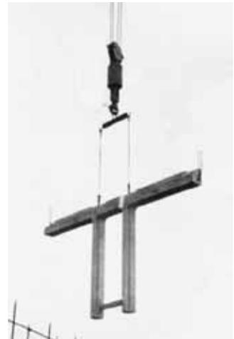
Die vorgefertigten Stützelemente dienen der schnellen Montage.
