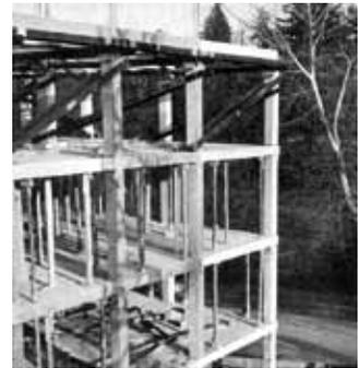
Die Kernform besteht aus vorgefertigten Stützen und Trägern. Diese werden ergänzt durch Fertiggeländer und Betonhourdis mit Überbeton.
