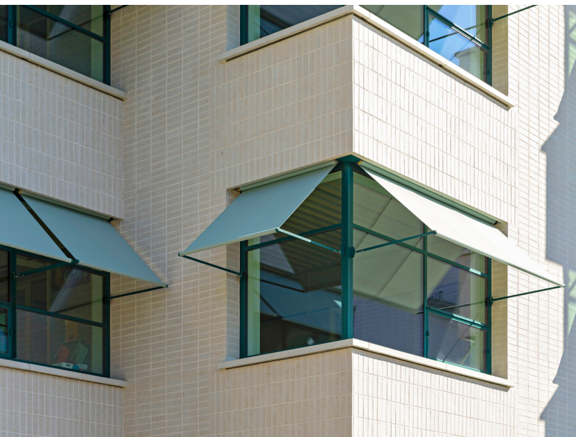
Im Wechselspiel verlegte Klinkerriemchen
