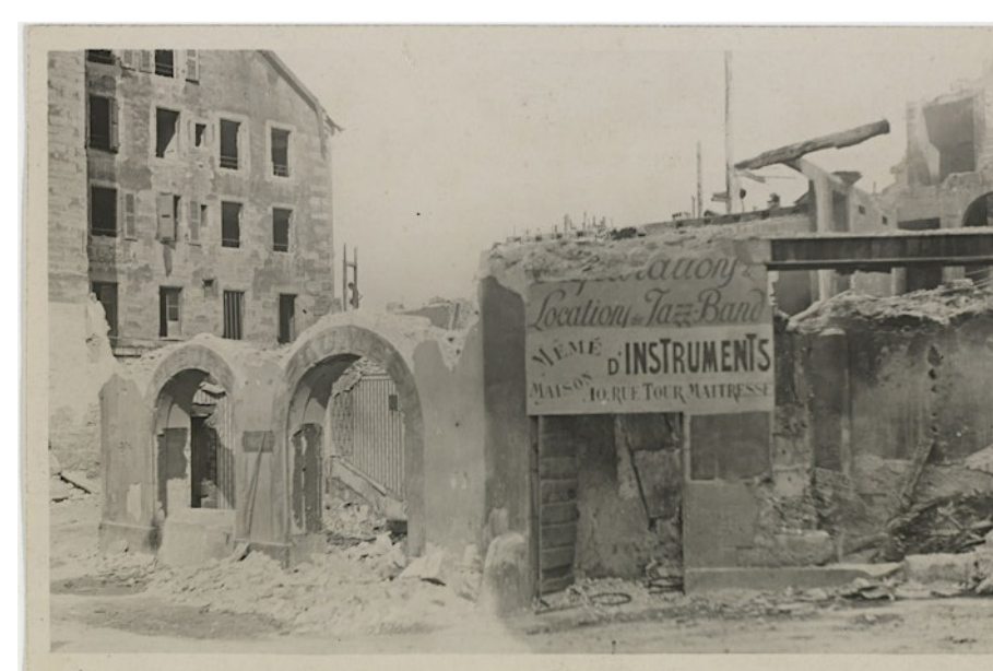
Démolition quartier du seujet, 1931.
