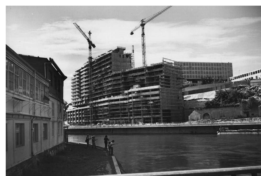
Construction bâtiments du Seujet, printemps 1974.
