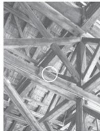
Abb. 96, Verbindung von Längsbalken über Stützen durch Stahldorne.
