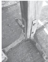
Abb. 95, Stahlwinkel an Posten.
