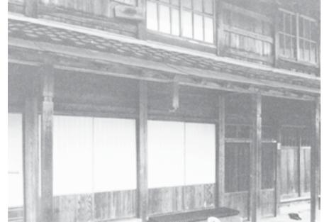
Abb. 103, Ausfachtung des Ständers durch feste und bewegliche Teile, Suganuma/Toyama, Japan.
