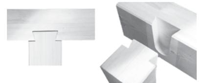
Abb. 116, Zeitgenössische Schwalbenschwanzverbindung.
